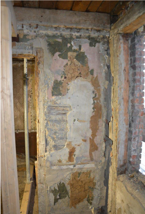
03 Vernakuläre traditionelle Art der nordischen Lehm-Holz Konstruktion (Lehmmörtelschicht zwischen Kantholz in Holzrahmen mit „rapping“ (norwegische Art von Lehmputz auf Holzoberflächen), im Wohnhaus Smedbakken 5 aus dem Jahr 1845/46 in Trondheim, Norwegen (Quelle: Autor)
