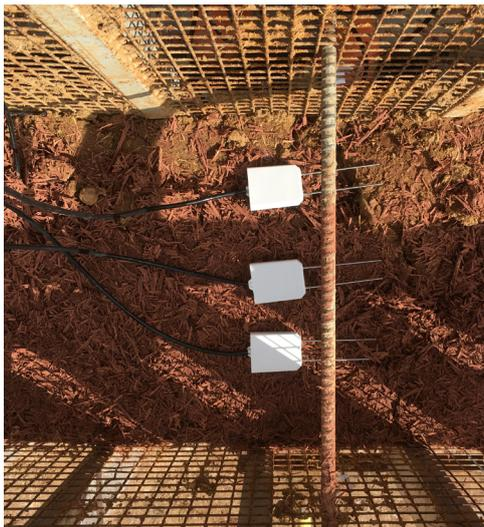
12 Installation von Sensoren zur Messung des Feuchtegehalts und des Wärmeaustauschs
