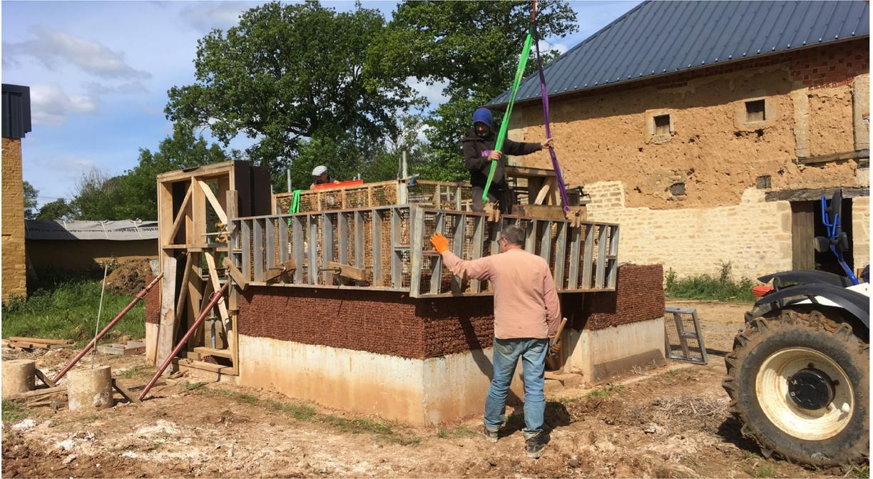
09 Ausrichtung von zwei Drahtgitter-Schalungselementen für die nächste Lage
