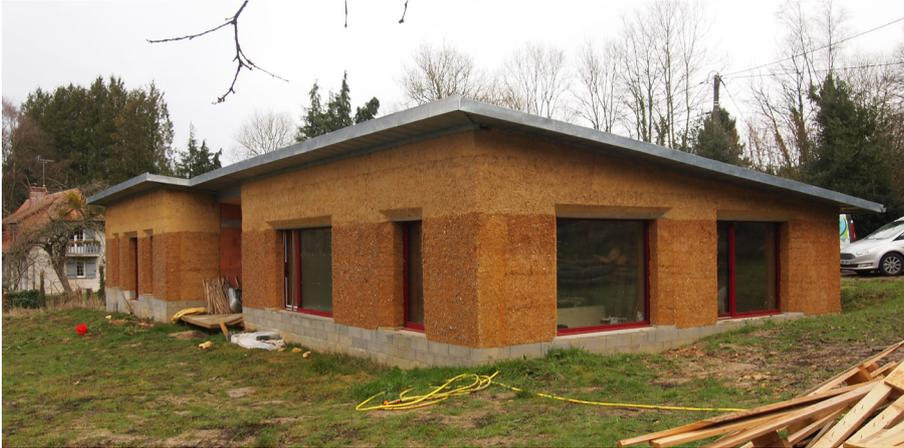
02 Wellerhaus in der Normandie bei Les Frères Bon, mit mehrschaligen Wänden aus zwei Lagen abgeschlossenen Wellerlehms und dazwischen liegenden Korkschäben
